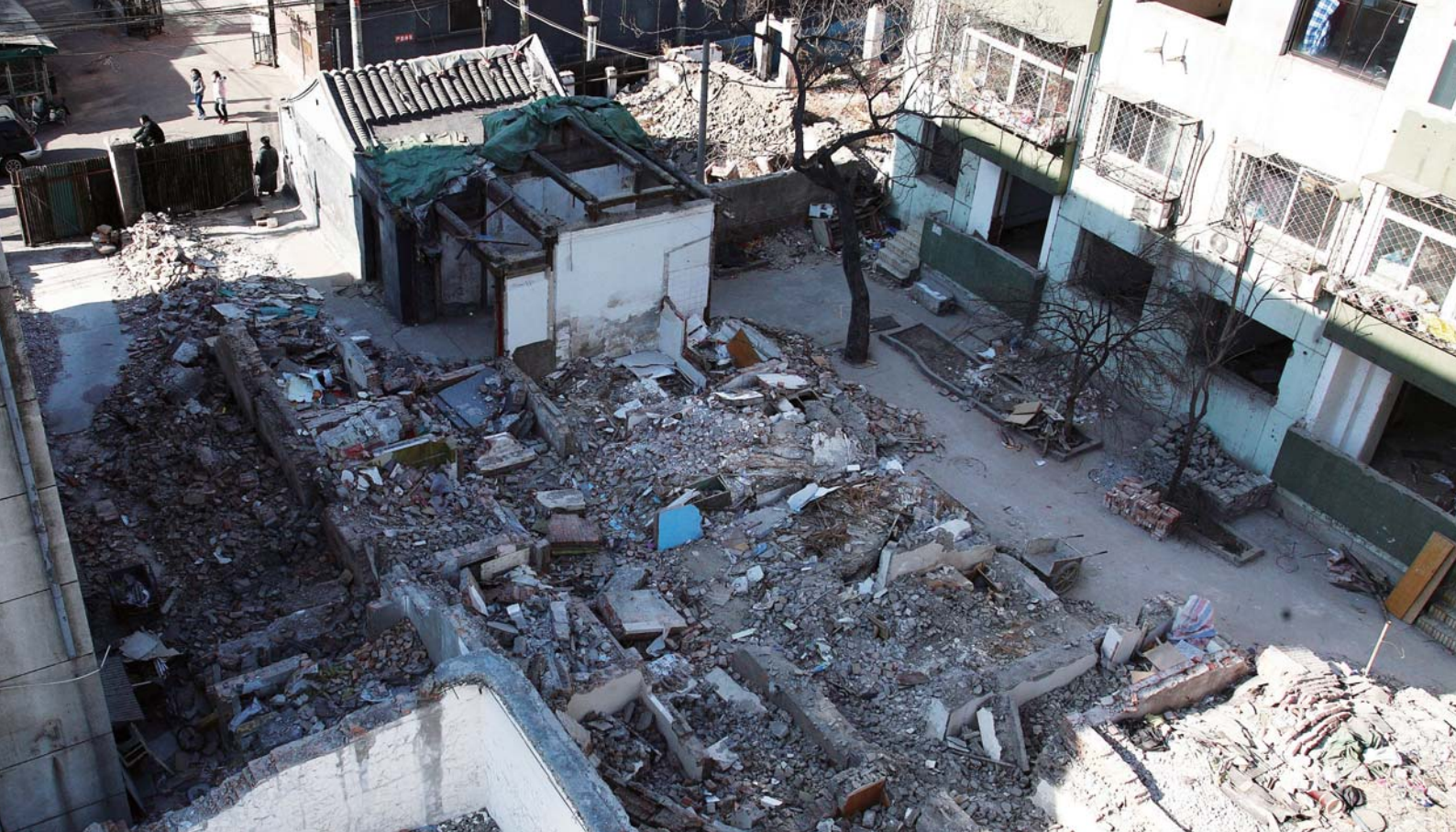
北京市東城区の廃墟と化した伝統的家屋「四合院」。1931年から1937年まで、有名な建築家夫妻、梁思成と林徽因の住まいで、文化遺産法で保護されていた。しかし、2012年1月に「メンテナンス」という名目で、建設業者に取り壊され、住民から激しい抗議の声が上がった。©AI
